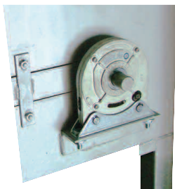
Système parachute latéral (axe non compensé)
