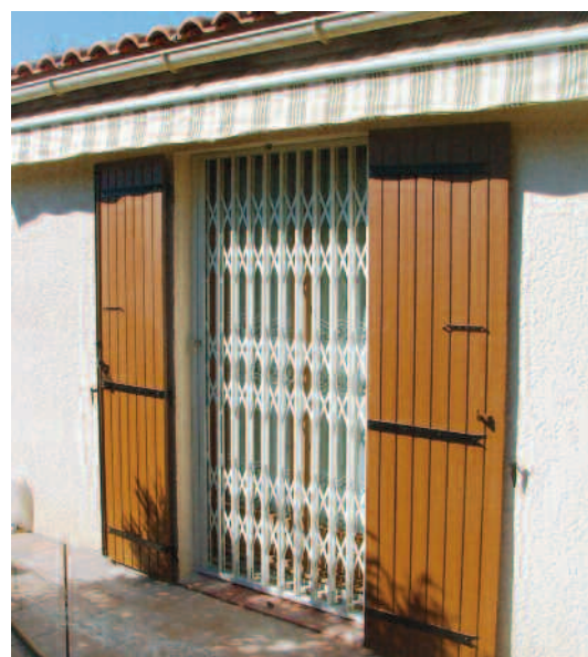
Pose entre chassis et volet
