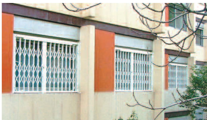
Pose en rez de chaussée d'immeuble
